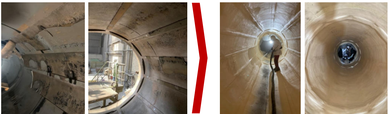
Neuauskleidung von Mischtrommeln mit REMAPUR 75
