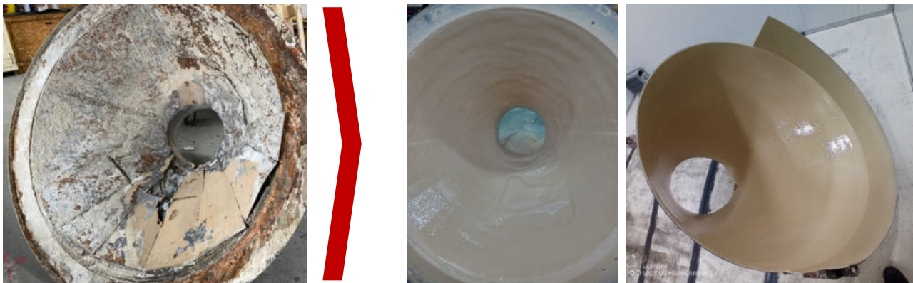
Sprühbeschichtung von Trichter
